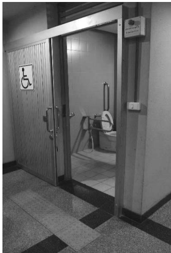
ประตูห้องน้ำเป็นบานเลื่อนอลูมิเนียม น้ำหนักเบา มีมือจับด้านนอก และขอสับด้านใน
